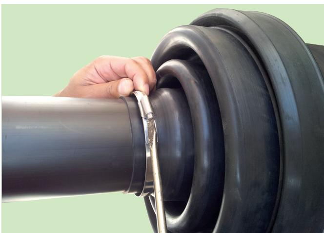
5. Nachdem die Manschette über beide Rohre geschoben ist, den Faltenbalg zum Schutz der Manschette komplett in den Ringraum schieben.
