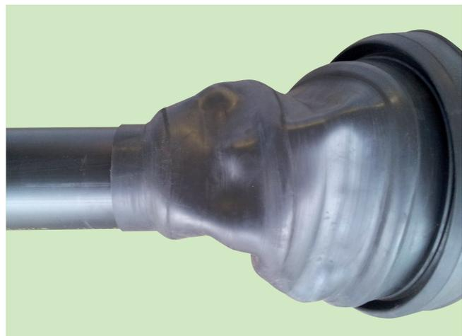
4. Anschließend die Manschette über das Medienrohr und das Schutzrohr schieben.
