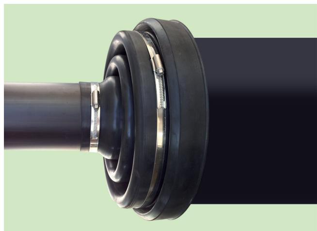
6. Abschließend die Manschette mit den Spannbändern am Medien- und Schutzrohr befestigen.
